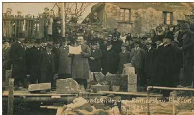
Grundsteinlegung zum Rathausbau Trebsen am 15. März 1924
