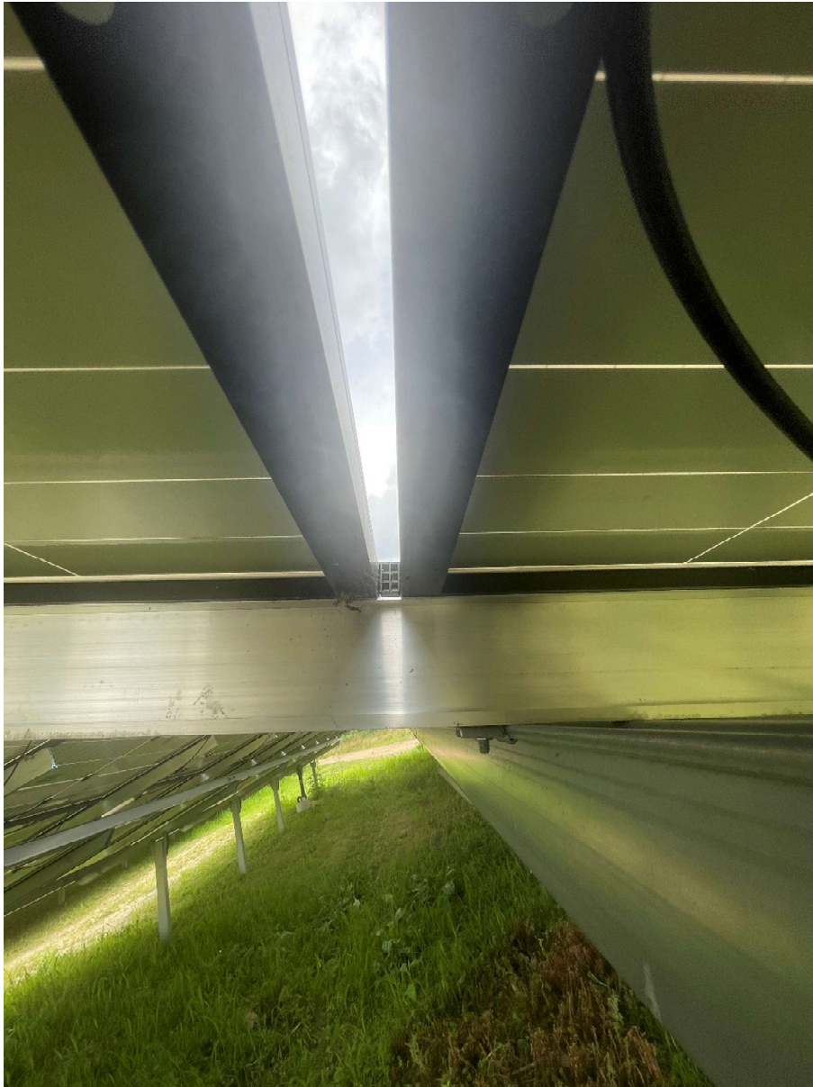
Abbildung 4: Lücken von ca. 2 cm Breite innerhalb der Modulflächen, durch die ebenfalls Niederschlagswasser auf den Boden gelangen kann
