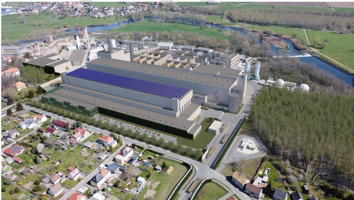
Abb. 9: Visualisierung des Referenzobjektes am Beispiel einer Papierfabrik, abgeleitet aus typischen, modernen Papierfabriken, Quelle: ges-consult, Stand 09/2021 zum Entwurf
