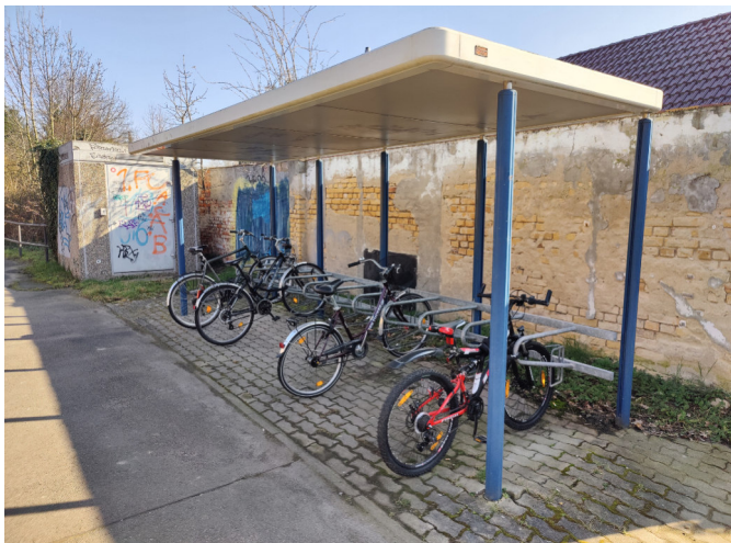
Abb. 41 Radabstellanlagen an der S-Bahnhaltestelle Altenbach
