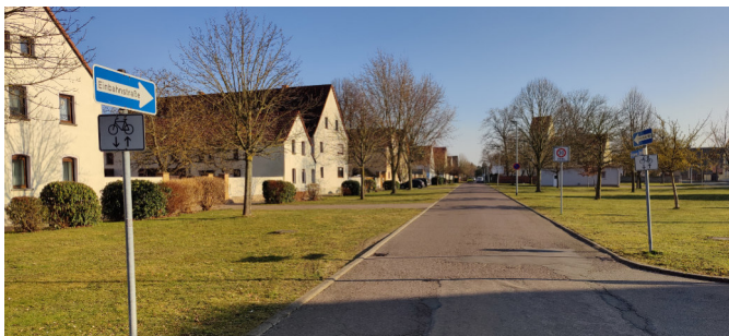
Abb. 37 Für den Radverkehr freigegebene Einbahnstr. in Deuben
