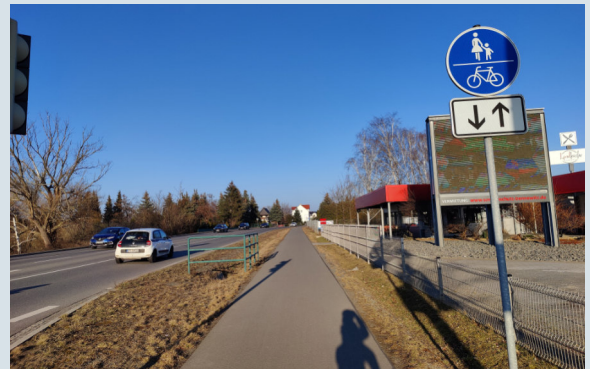
Abb. 27 Gemeinsamer Geh- und Radweg bei Deuben
