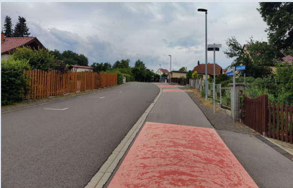
Abb. 23 Für den Radverkehr freigegebener Gehweg in Bennewitz/Altenbach
