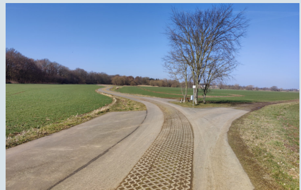
Abb. 25 Wirtschaftsweg südlich von Rothersdorf
