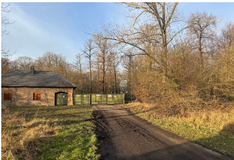
Abb. Eingangsbereich zum Muna-Gelände von der Straße zur Muna
